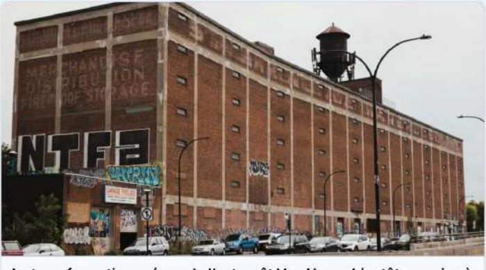
La transformation prévue de l'entrepôt Van Horne bientôt soumise à l'OCPM L'illustre bâtiment patrimonial du Mile End pourrait accueillir un hôtel et des ateliers d'artistes. © www.ledevoir.com
