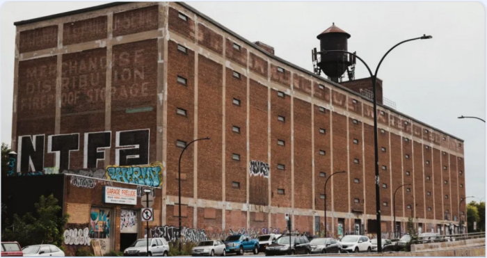
La transformation prévue de l'entrepôt Van Horne bientôt soumise à l'OCPM L'illustre bâtiment patrimonial du Mile End pourrait accueillir un hôtel et des ateliers d'artistes. © www.ledevoir.com
